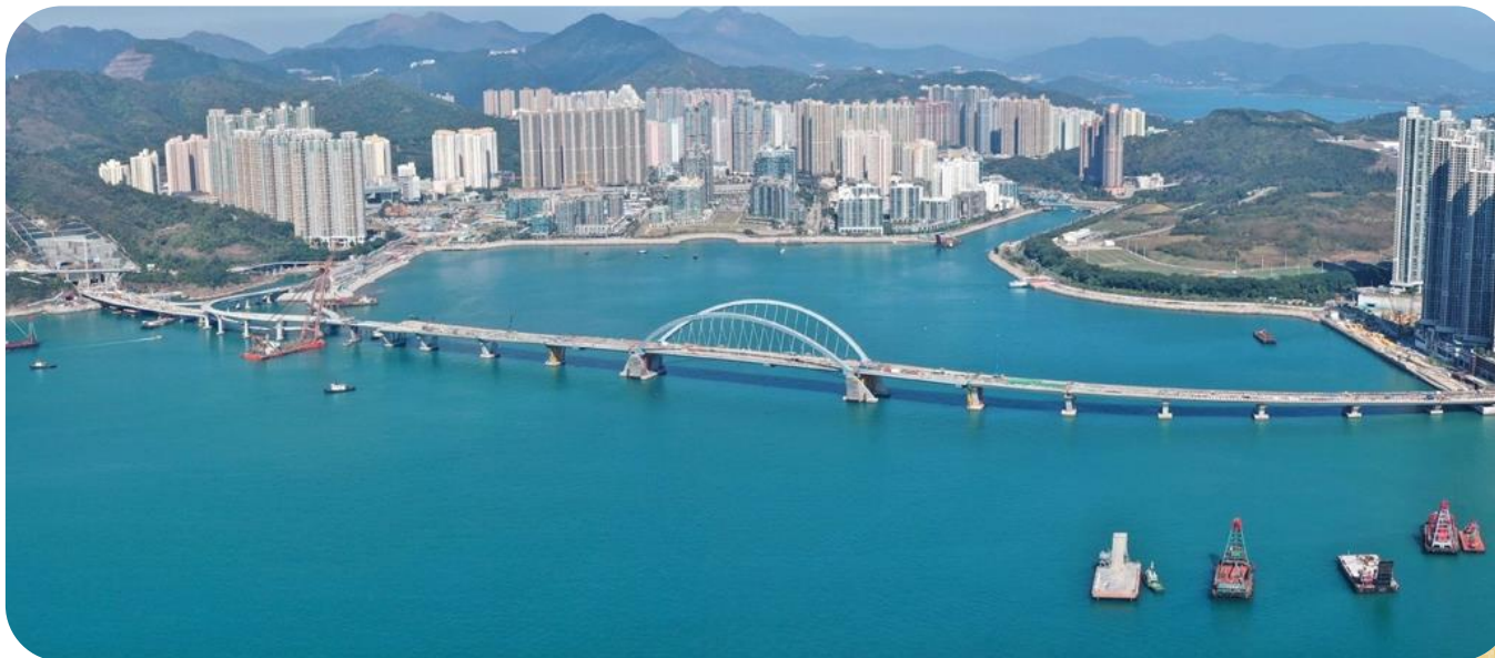
跨灣連接路 Cross Bay Link
