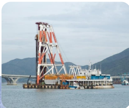
深層水泥拌合工程船 Deep cement mixing barge
