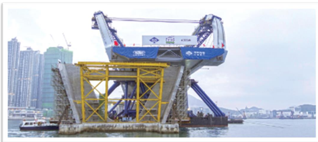
全跨橋面浮托 Whole-span “float-over” erection
