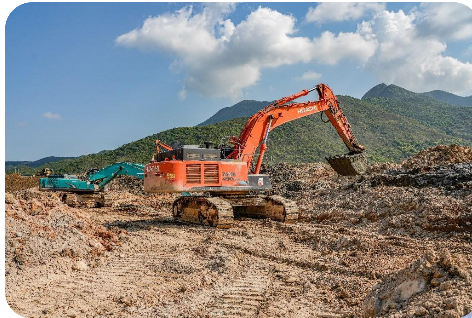
填土工程進行中 Earth filling works in progress
